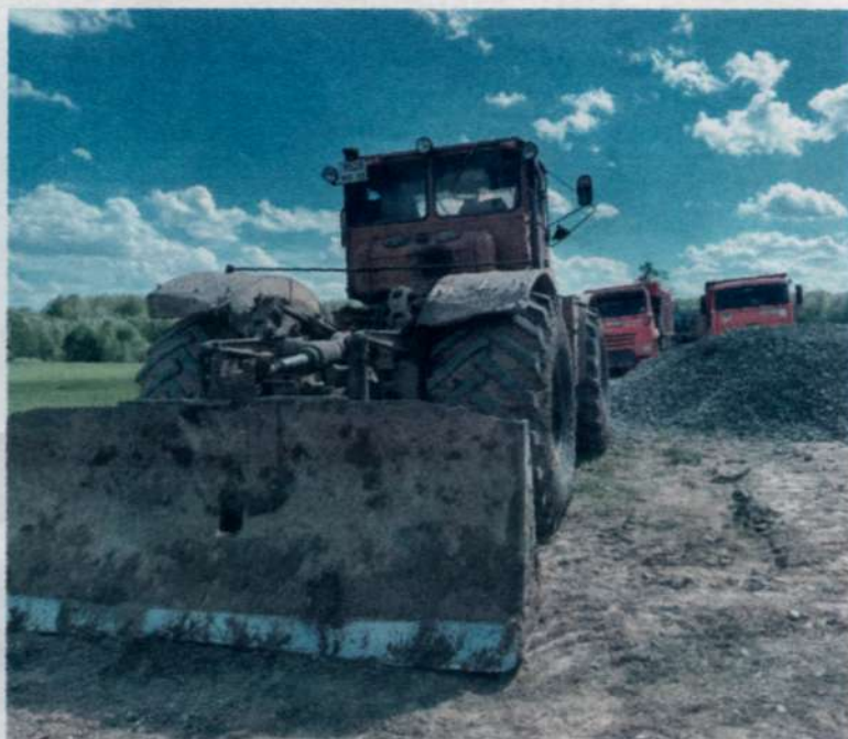
В дорожных работах задействована техника ДРСУ-5.
